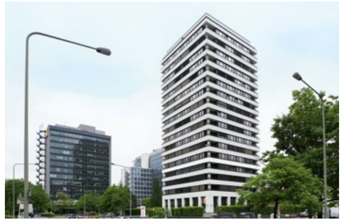
Pionier: Als erstes Gebäude wurde das Hochhaus an der Lyoner Straße 19 in ein Wohnhaus umgebaut. 98 Wohnungen sind entstanden.
