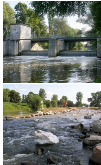
Sossenheimer Wehr heute (rechts oben), Planungsentwurf für den Umbau mit Streichwehr und wieder angeschlossenen Grill'schem Altarm
