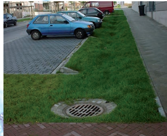
Mulden-Rigolen-System im Baugebiet Hannover-Kronsberg Quelle: Stadtentwässerung FfM
